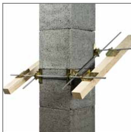
Usztywnienie kominu w miejscu przejścia przez dach.
