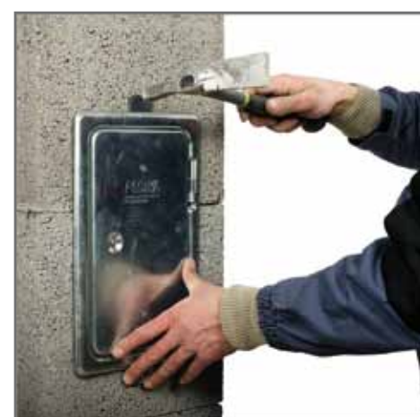
Zewnętrzne drzwiczki czyszczaka mocujemy za pomocą gwoździ (papiaków).
