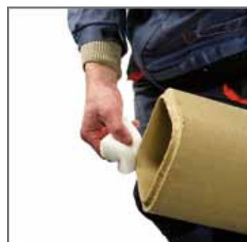
6. Oczyszczyć wilgotną gąbką pióro-wpust ceramicki.
